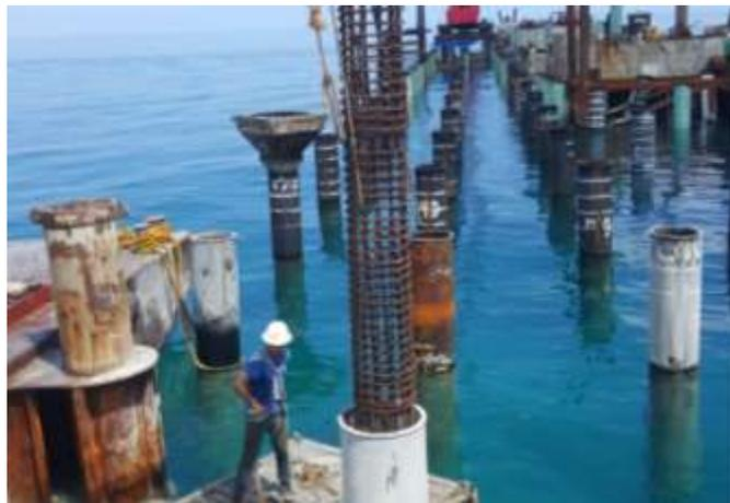
*Fig. II.10 Colocación de armado dentro del tubo de acero.
