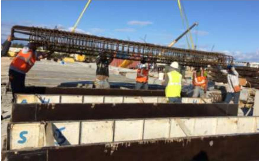
*Fig. II.14 Colocación de armado en la cimbra*
