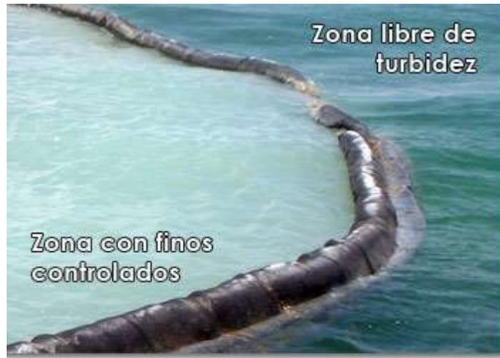
Figura VI-2. Colocación de geotextil para control de sólidos re-suspendidos
