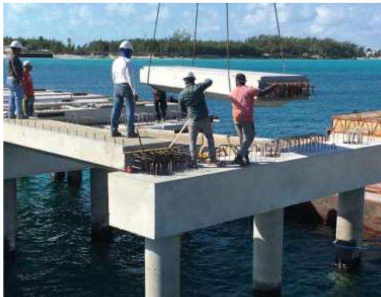
*Fig. II.17 Montaje de losas prefabricadas*
