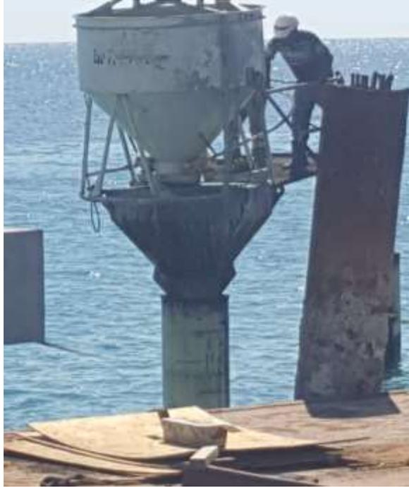
*Fig. II.11 Colado con concreto para fijar el acero de refuerzo.
