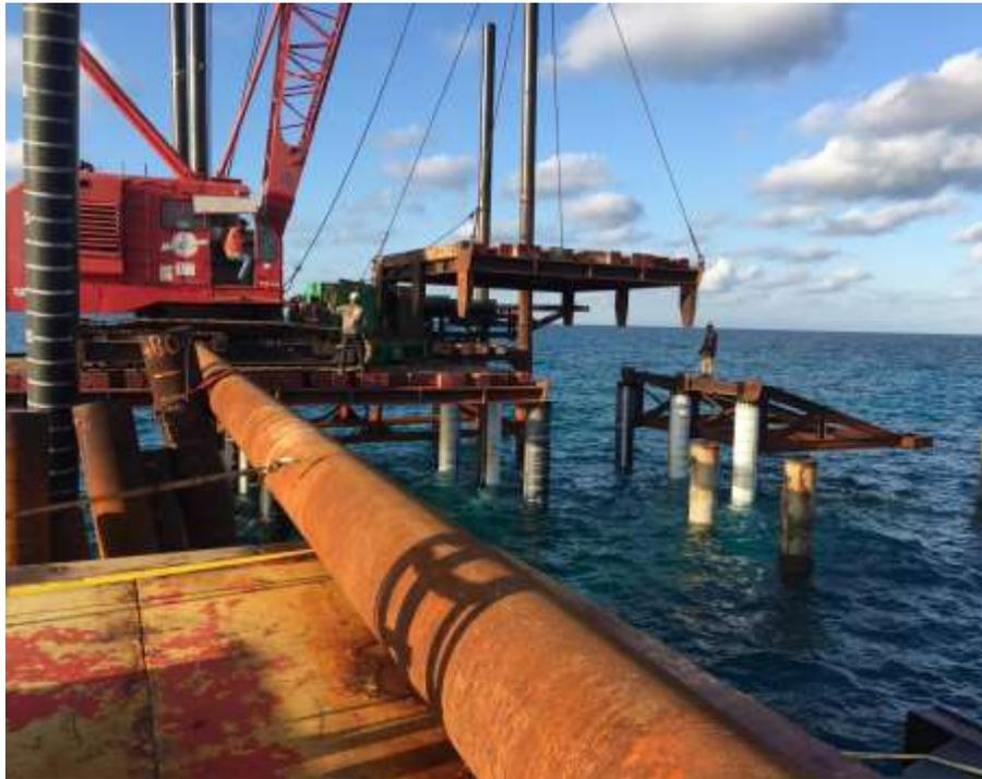
*Fig. II.6 Tubos de acero para pilotes.*
