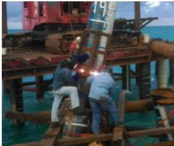
*Fig. II.8 Acoplamiento de sección de tubo.
