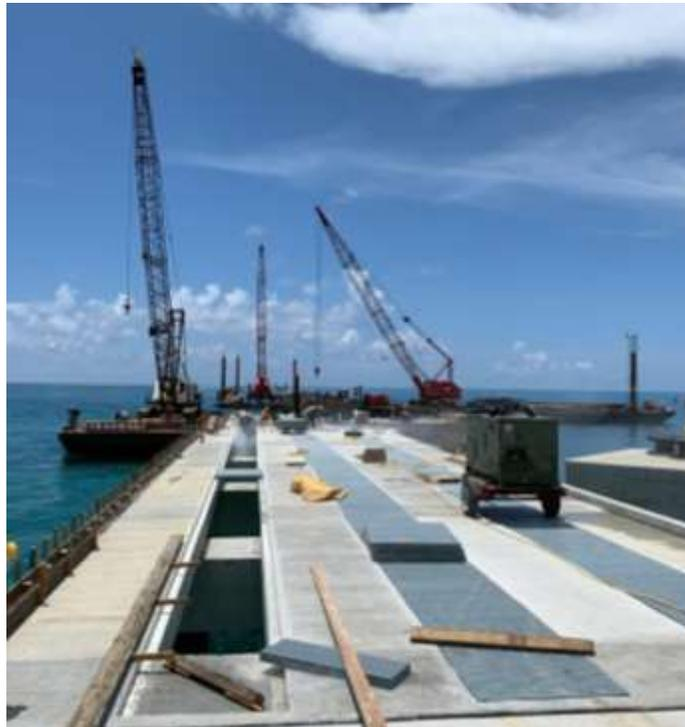
*Fig. II.21 Colocación de rejillas tipo Irving.
