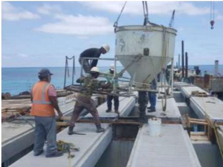
*Fig. II.19 Colado con concreto de uniones entre traves y losas.*
