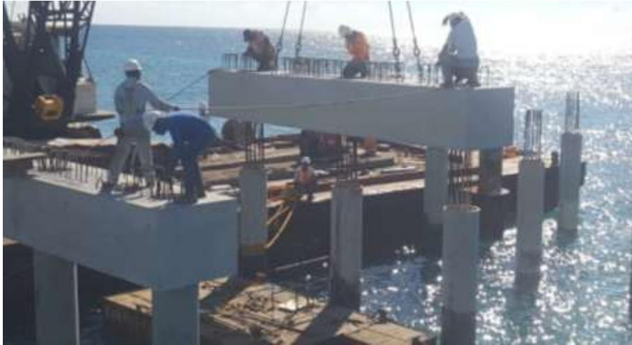
*Fig. II.16 Montaje de travesaños prefabricados.*
