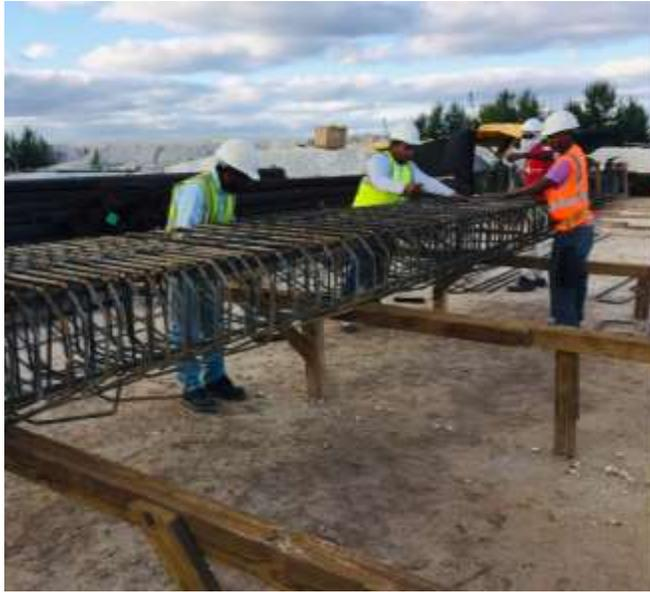
*Fig. II.12 Armado de acero de refuerzo para traves.*
