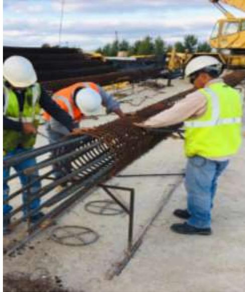
*Fig. II.9 Armado de estructuras internas para los pilotes.
